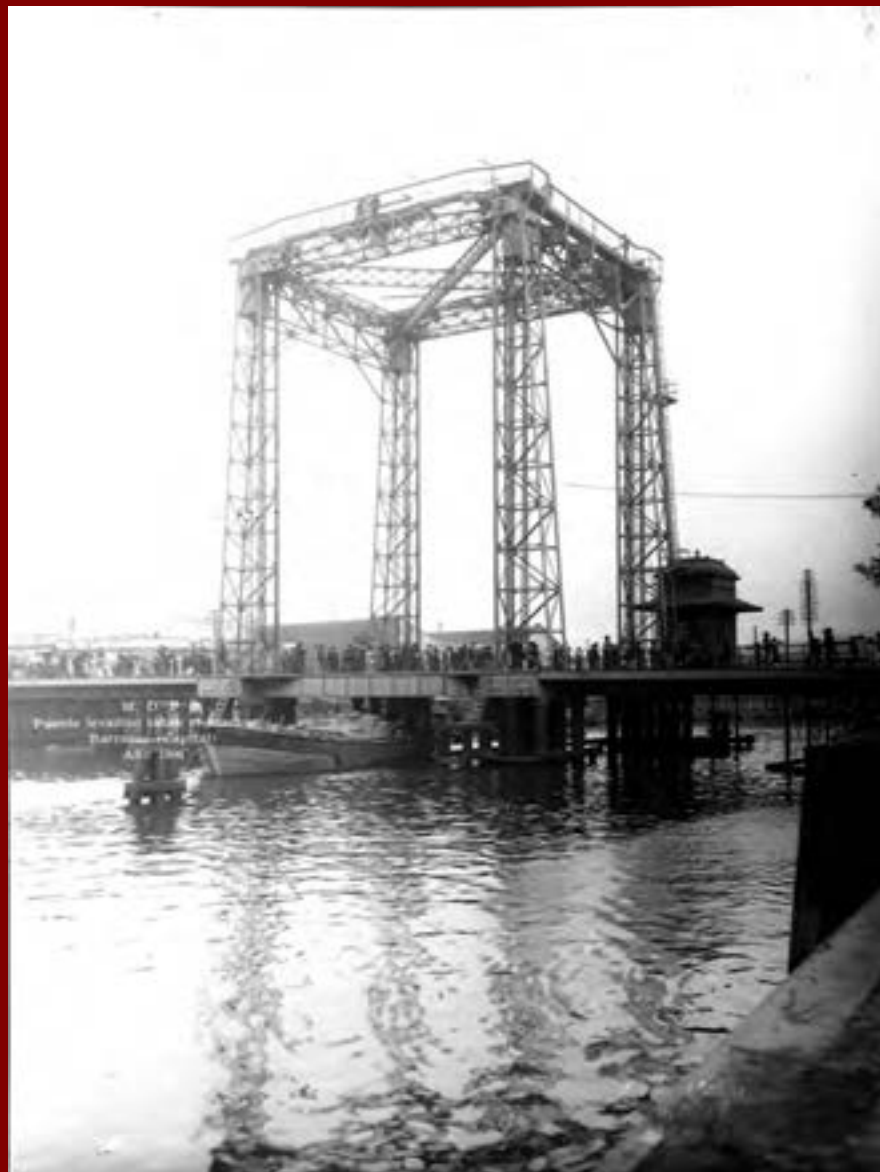
M.O.P - Puente levadizo sobre el Riachuelo - Barracas- 1904-
