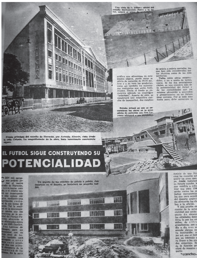
Foto 17. LC, núm. 879, 28 de marzo de 1945. Construcción del estadio del Club Atlético Huracán y de la sede social y deportiva del Club Atlético San Lorenzo de Almagro
