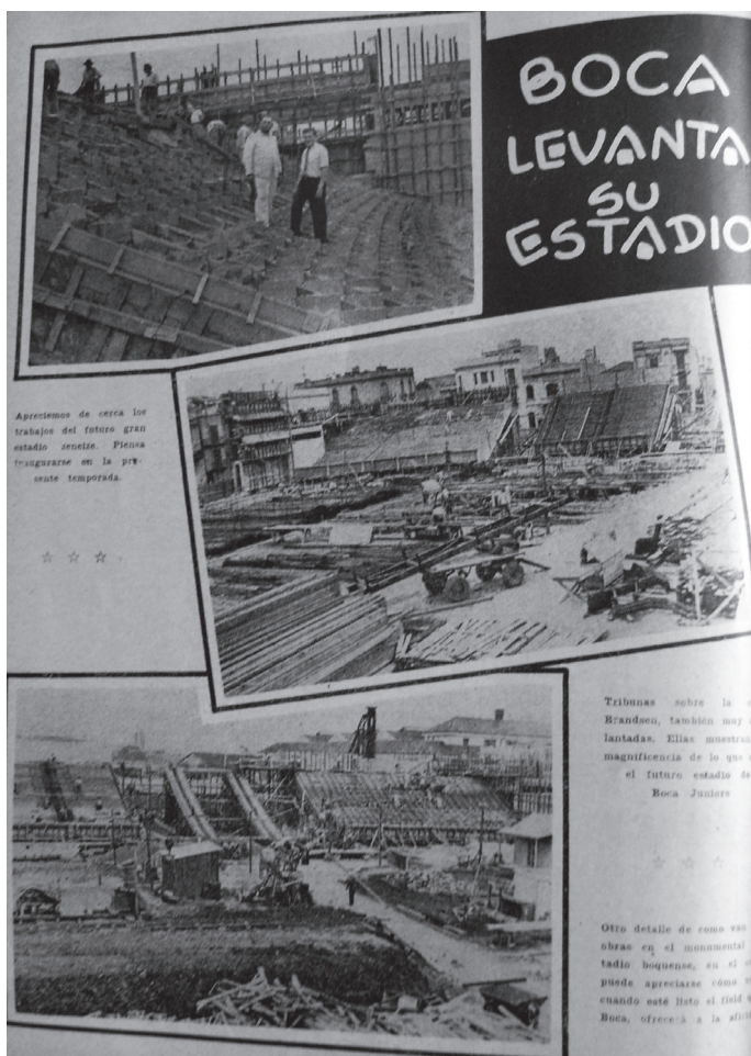
Foto 4. LC, núm. 562, 1 de marzo de 1939. Construcción del estadio del Club Atlético Boca Juniors
